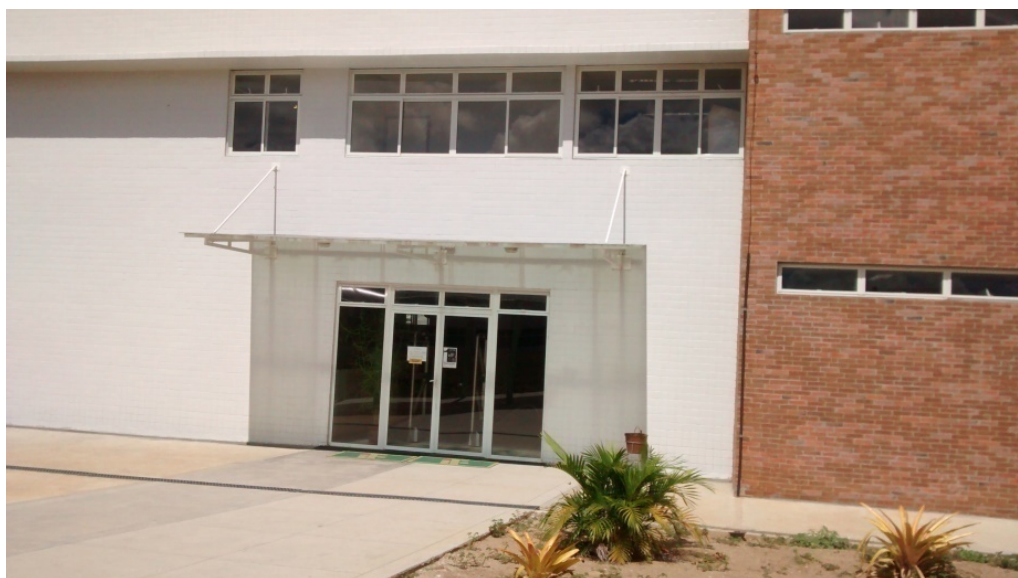
Vista da entrada da biblioteca do campus.
