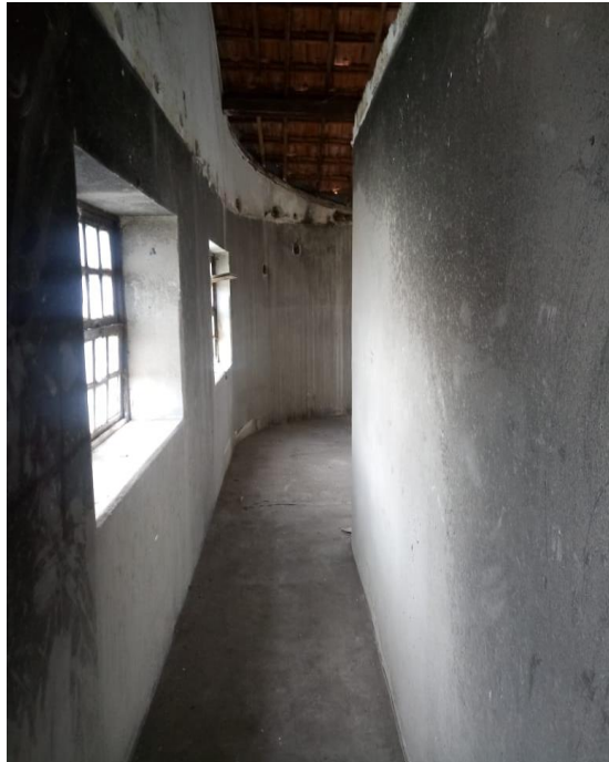
Figura 09 – Alvenaria atingida pelo fogo
