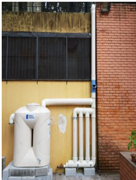
FIGURA 23 - Sistema de Captação de Água da Chuva Implantado pelo ESF-SP
