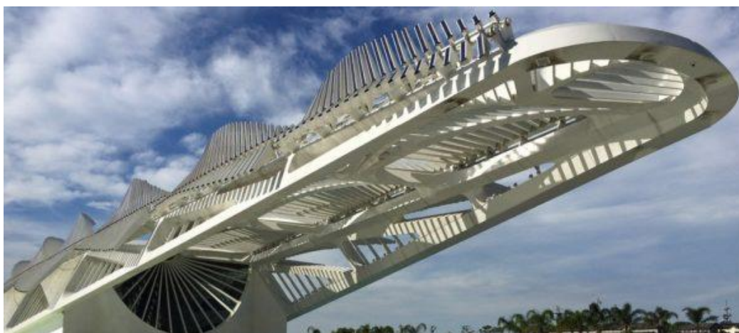
FIGURA 16 - Estrutura móvel do Museu do Amanhã que serve de brise e contém placas fotovoltaicas para captação de energia solar, Rio de Janeiro
