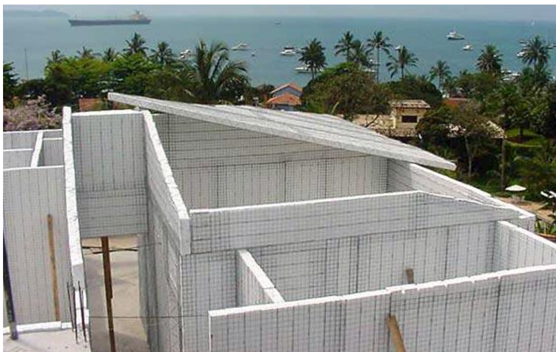
FIGURA 15 - Painéis sendo montados em uma obra residencial no litoral de São Paulo
