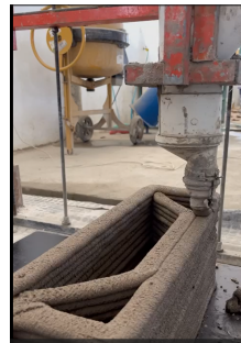
b) mini-parede 3DCP em construção e construída no IFPB
