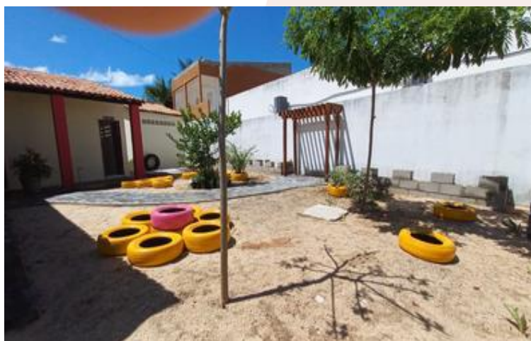
Figura 2 - CRAS/ Quixaba durante a execução do jardim.
