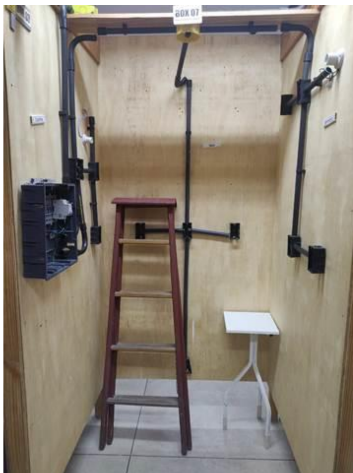
Figura 4 –Fotografia do Laboratório de Instalações Elétricas Cabines Individualizadas– IFPB-Itabaiana.
